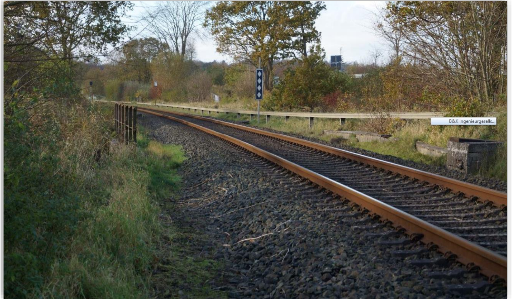
[Quelle - Geotechnischer Bericht – Erneuerung EÜ Goosbek in km 28,085; Nr 3.762 vom 23.10.2019; Ingenieurgesellschaft Grundbauinstitut]
